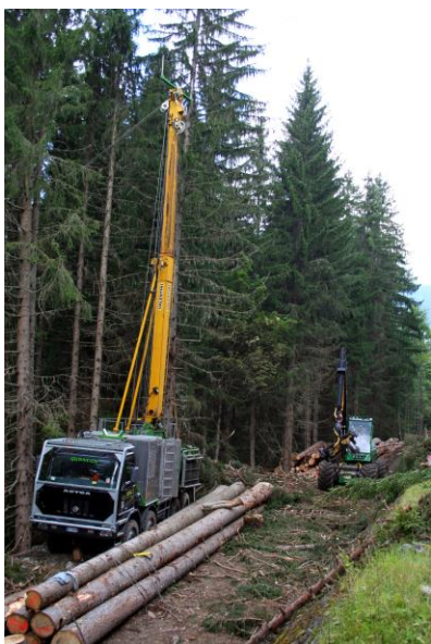
Photo 2 : Câble mât longue portée sur la plateforme d'un camion
