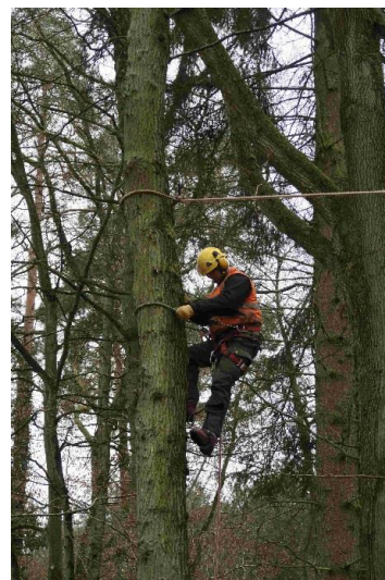
Photo 4 : Installation du câble par un grimpeur formé et équipé (harnais, longe de sécurité, griffes et casque)
