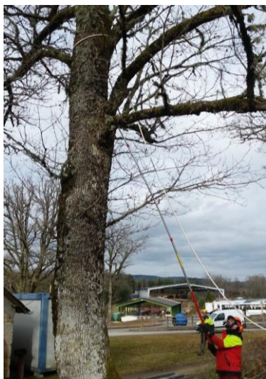
Photo 2 : Utilisation de perche télescopique + élingue synthétique pour accrocher en hauteur depuis le sol
