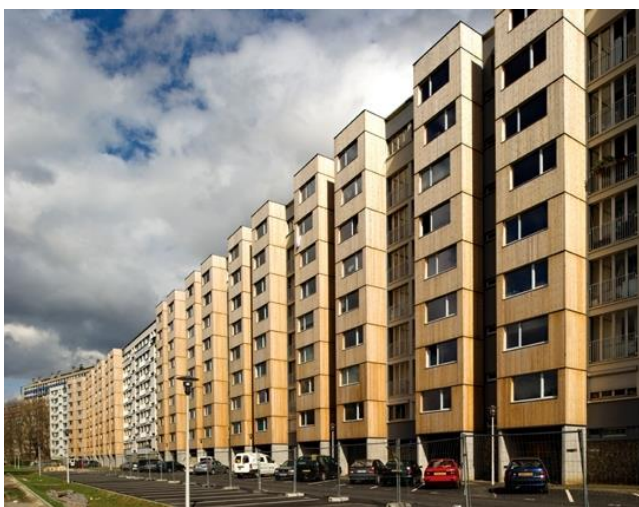
Figure 2: Épaississement par pose de plugs en bois en façade - Résidence dans le quartier de la Noue Caillet à Bondy (2010)
