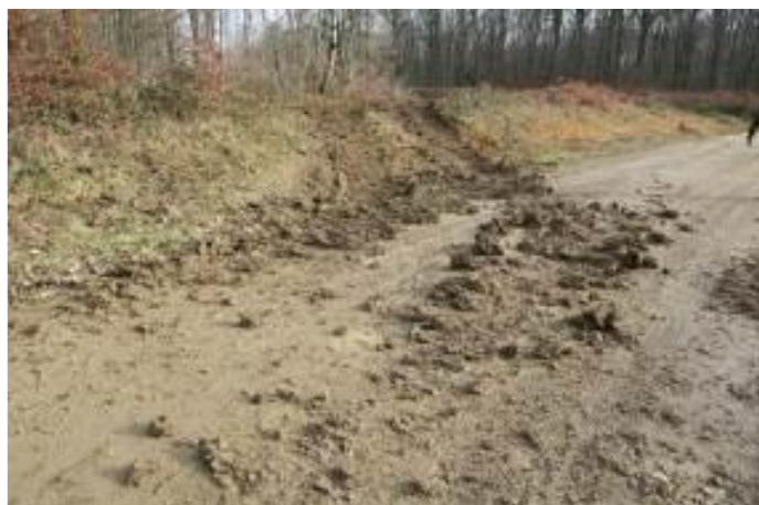
Photo 5 : Terre ramenée sur la piste
