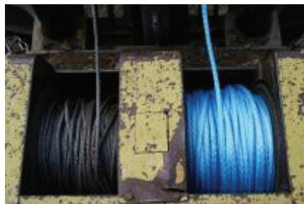
Un bon enroulement sur le tambour du treuil
