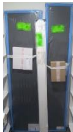
Photo 8 : Emballage façades de placard
