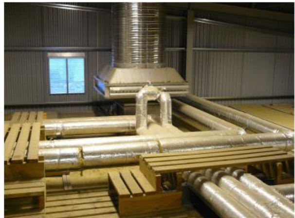
Photos 3 et 4 : Isolation et échangeurs installés dans les séchoirs pour récupérer un maximum de chaleur (Photos : ECOINFLOW)
