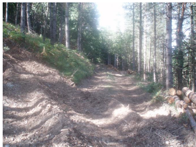
Photo 1 : Talus et stockage de bois dans les chantiers en pente
