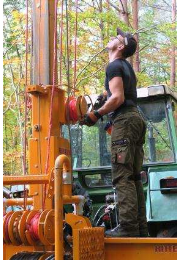
Tension manuelle des haubans
