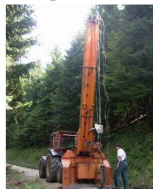
KurzStreckenseilkrane Ritter sur l'un des chantiers à Freiburg
