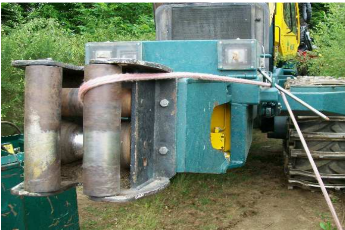
Remplacement du câble synthétique après épissure
