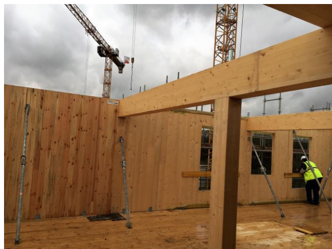
Photo 2 : Phase intermédiaire de la mise en œuvre du CLT sur le chantier à Ris Orangis (91)
