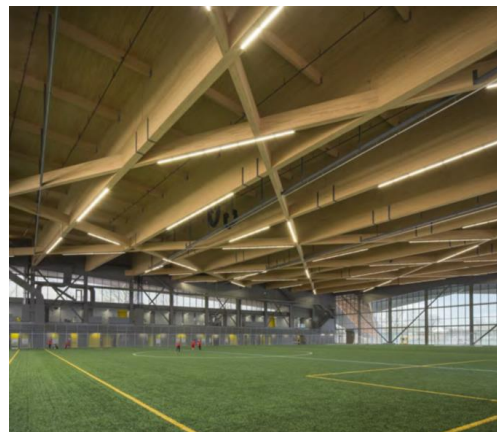
Photo 6 : Stade de Soccer CESM à Montréal La structure principale comporte treize poutres-caissons droites. Chaque poutre pèse 77 t. – Crédit photo NORDIC STRUCTURE
