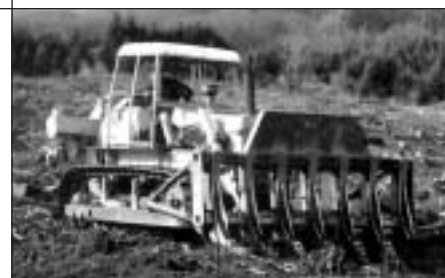
L'andainage a été notamment réalisé à l'aide d'un bulldozer équipé d'un râteau à dents.
