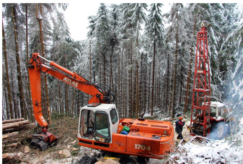
Photo 1 : Câble mât et engin de reprise
