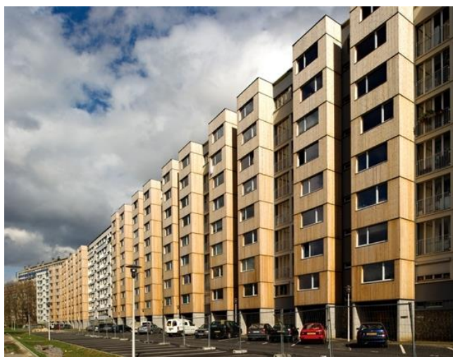
Figure 2: Epaissement par pose de plugs en bois en façade - Résidence dans le quartier de la Noue Caillet à Bondy (2010)
