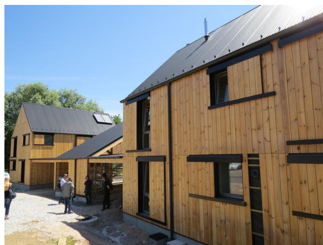
Figure 6: Bat'innovant en fin de chantier (crédits photos : Thibaut Surini, Fibois)
