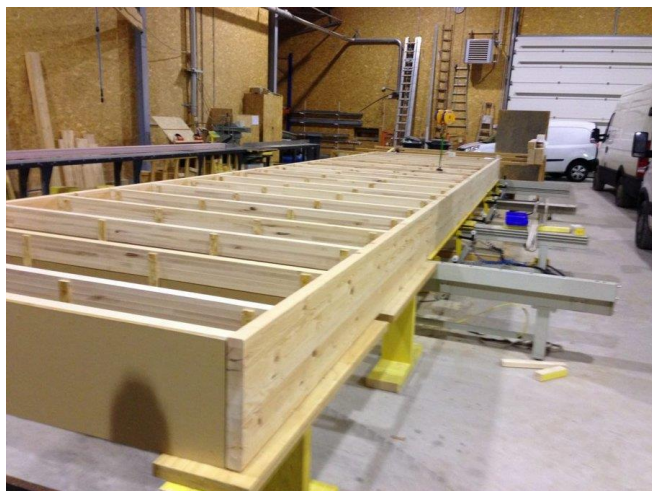
Figure 5: Assemblage des murs - MOB Alsace – Durrenbach (source : MOB Alsace)
