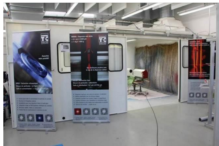
Figure 11 : vue extérieure de la cabine d'application à filtration sèche Frachon et emplacement du banc de mesure HELOS KR durant les essais (photo FCBA)
